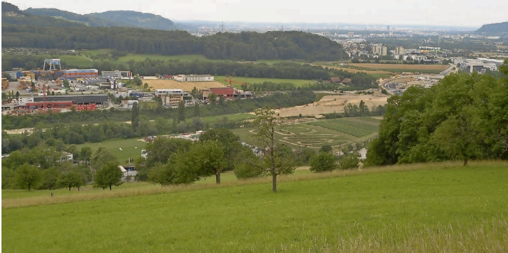
Blick auf Hüftenschanze und H2-Baustelle: Siedlungsentwicklung im Oberbaselbiet erfordert neue Strassen in Richtung Basel.
